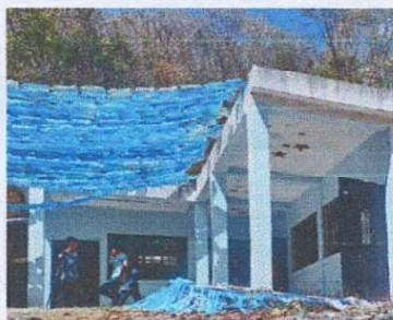
Foto 1: Pintura en Muros exterior e interior
