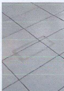
Foto 5: Sustitucion de piso ceramico por piso antideslizante.
