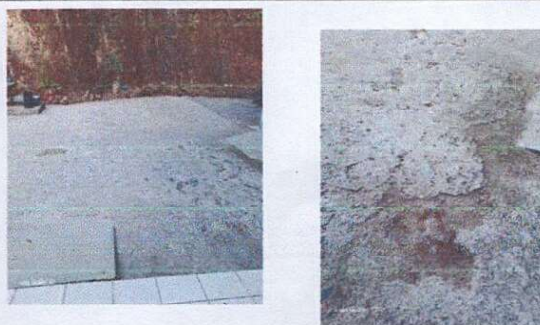
Foto 6. se sustituir losa de patio por una nueva ya que la que esta tiene varias partes muy mal estado con orificios.
